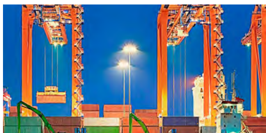
Lyft och kranar
